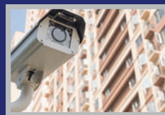
24 Hrs CCTV Surveillance
